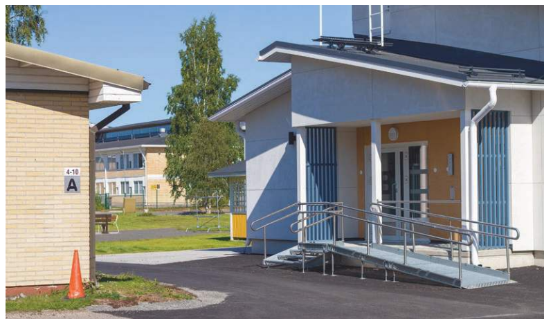
Vanhan A-talon kunto selvitetään, kun taas upouusi B-talo ei hetkeen tarvitse toimenpiteitä.
